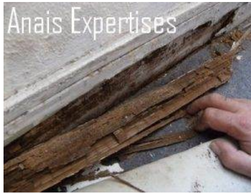
Pourriture cubique liée à la présence d'un mэрule
